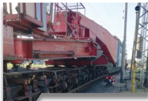
Bild 1: Millimeterarbeit beim Transport eines 273 t Transformators im HPA-Gleisnetz. (Foto: Frank Lackmann, HPA)
